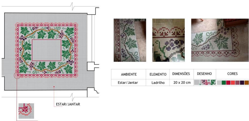
Figura 1: Desenho de Piso. Trata-se de um piso raro, tipo ladrilho feito em mosaico - projeto datado de 1928. A direita desenho do piso mosaico feito durante a disciplina, a partir de software de desenho métrico; a esquerda fotos do piso da sala de estar/jantar da residência estudada, feitas durante o levantamento arquitetônico. Imagens de Carolina Alves (2017).
