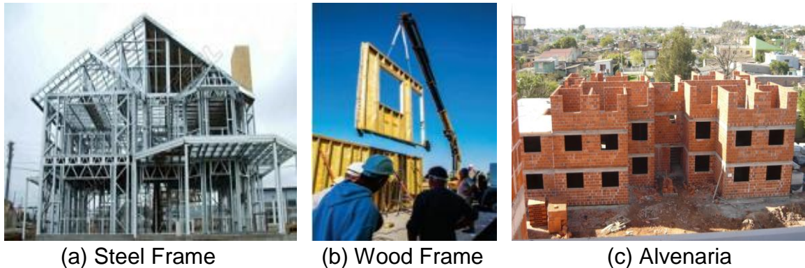
Figura 1 – Imagens dos sistemas construtivos em, Steel e Wood Frame e em alvenaria portante. Fonte: (a) Steel Frame Nova Lima (b) Roberto Ferreira Comercial e Construtora Ltda (c) Autores.
