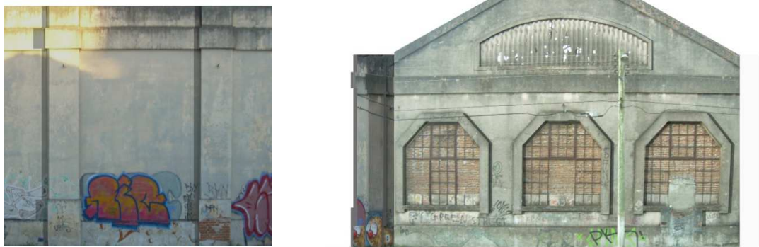
Figura 1: Retificação das fachadas da antiga cervejaria Sul Rio-Grandense. Fonte: SALABERRY, J. D.; SILVA, A. B. A., 2010.
