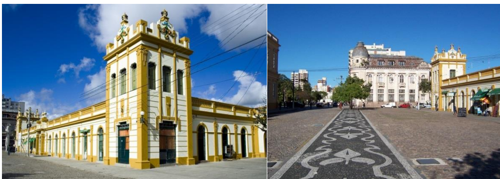
Figura 04– Fachada do Mercado Central após a restauração. Fonte: Site do Programa Monumenta
