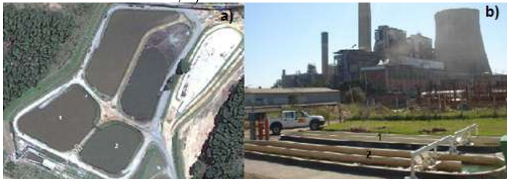
FIGURA 1 Pontos de coleta das amostras de água: a) Lagoas de decantação de cinzas; b) Biorreatores desativados
