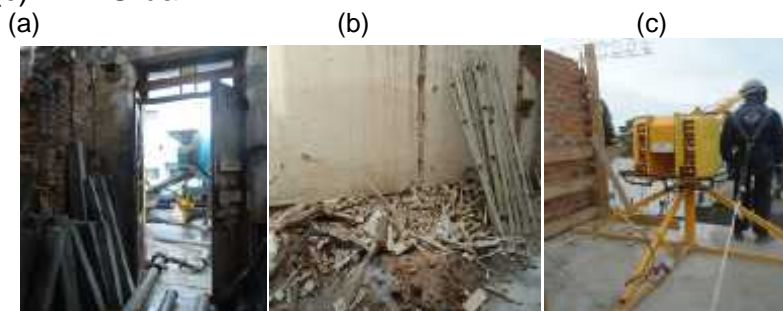
Figura 3- Sistema de Movimentação de materiais(a) Vias de circulação (b) Entulhos(c) Mini-Grua
