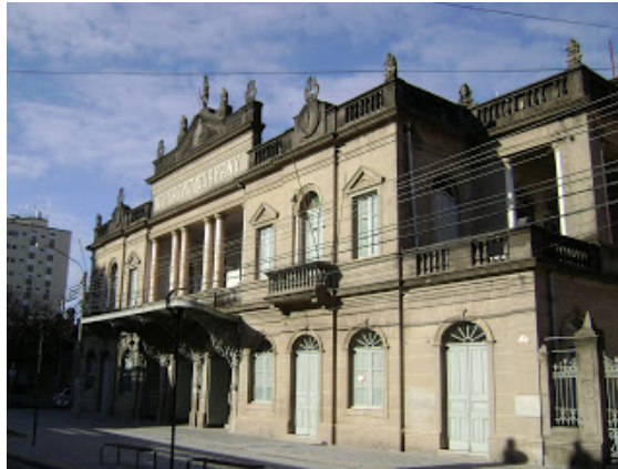
Figura 3 – Fachada do Theatro Guarany
