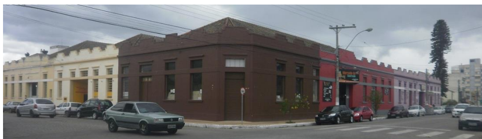
Figura 2: Conjunto de galpões localizados na Rua Padre Felício, entre as ruas Santos Dumont e Barão de Santa Tecla
