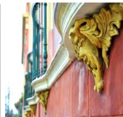
Figura 3: Gárgula impressa em 3D da parte inferior das janelas e fachada de onde foi gerada a fotogrametria. Fonte Arquivo pessoal do autor.
