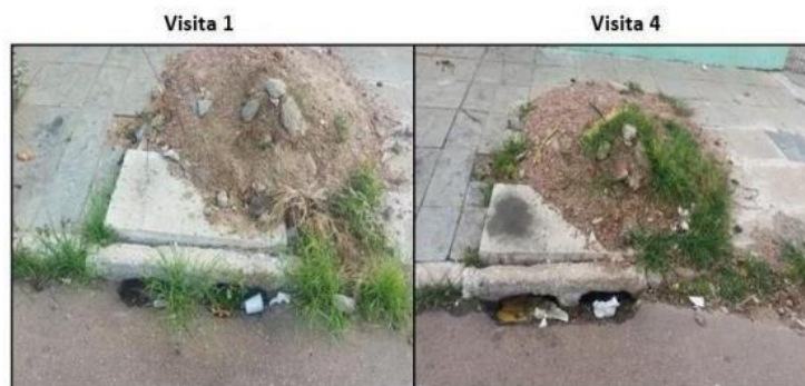
Figura 2: – Fotografia do uso inadequado da boca de lobo.
