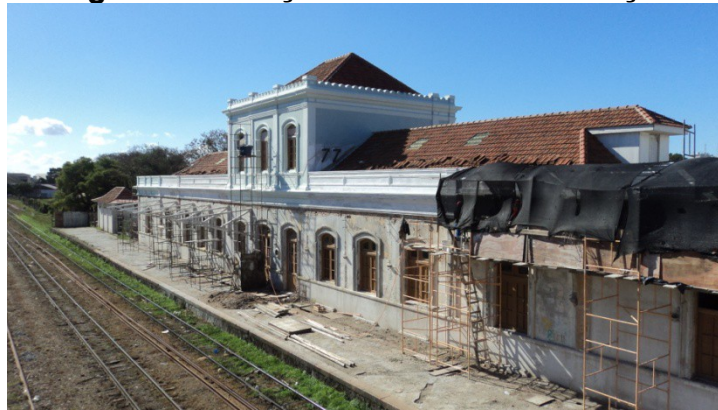
Figura 3 - Estação férrea em restauração
