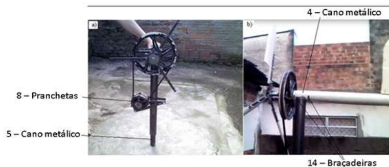
Figura 3 - Imagem a) Usinagem do cano 5 para encaixe no rolamento especial que contém o cano 4 e soldagem da prancheta 8 para atuar como suporte do alternador; b) Soldagem de um pedaço de cano 4 no cano 4, perpendicular, e colocação do leme segurado pelas braçadeiras. Fonte - Pelo autor.
