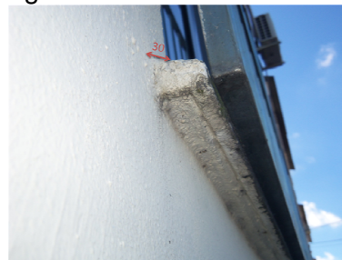
Figura 4: Detalhe das pingadeiras das janelas. Foto da autora.
