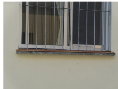
Figura 8: Colocação de material cerâmico no peitoril. Foto da autora.
