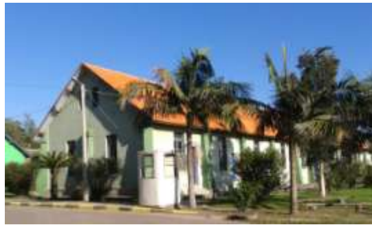
Figura 1 – Vista externa do Prédio 58, Câmpus Pelotas Visconde da Graça (CaVG) – IFSUL.
